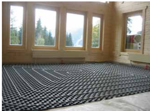
Podlahové vytápění se systémovými součástmi - nopové desky
