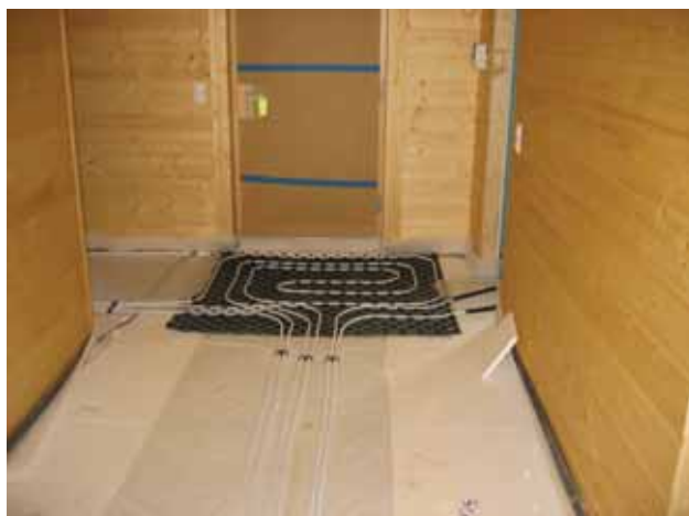
Distribuční potrubí a plošné vytápění v podlaze
