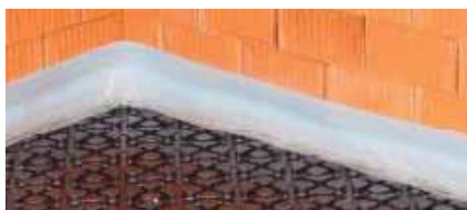
Okrajová izolační páska kolem stěn a sloupů
