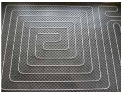
Bifilární instalace s nopovými deskami
