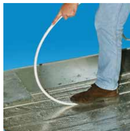
Pokládka topných trubek
