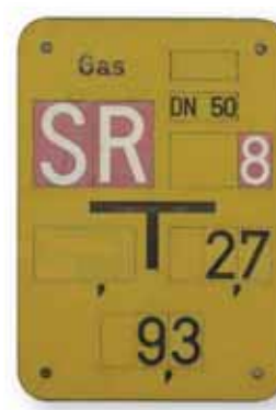
Údaje o umístění uzavíracího šoupátka.
