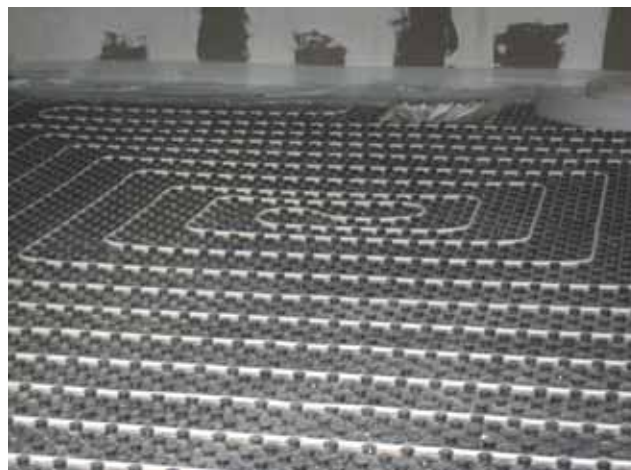
Šnekové uspořádání s nopovými deskami
