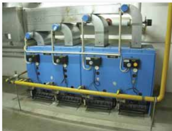
Atmosférický 4-stupňový plynový kotel
