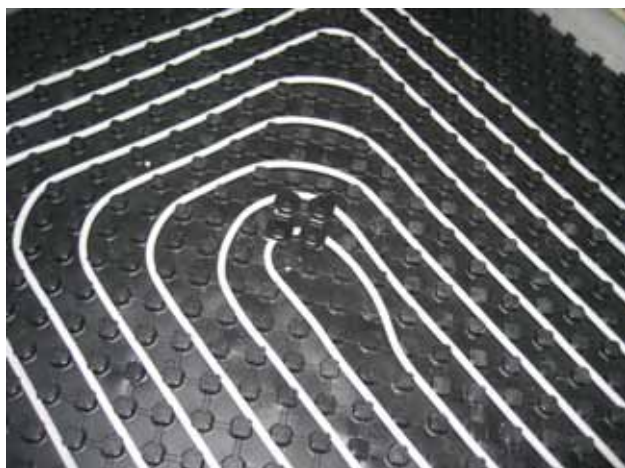
Podlahové vytápění se systémovými součástmi - nopové desky
