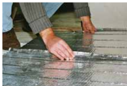
Instalace přívodních desek a překrytí lepicí fólií
