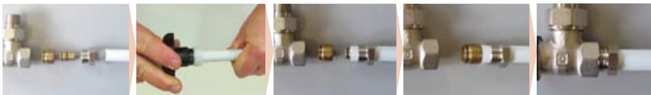
Rúrku odrezať pod pravým uhlom a odhrotovať jej okraje. Tlakovú skrutku navliecť na rúrku a zasunúť závitovú prechodku.
