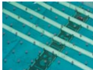
okrajová zóna podlahového vykurovania
