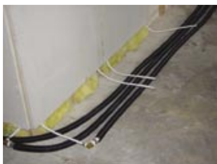
Pripojenie stenového vykurovania
